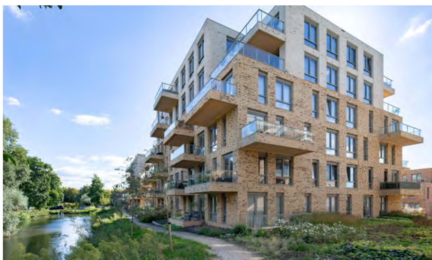
bebouwing met een verbindende relatie tot het groen en het water Robijnhof, Leiden, LEVS
