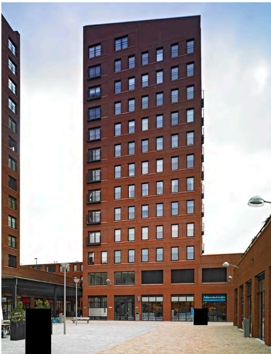
mono materiaalgebruik en ritme; gebrek aan diversiteit Winkelcentrum Leidschenvveen, awg Architecten
