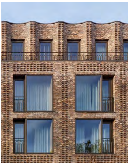
gelaagde gevelopbouw Pillows, Amsterdam, Office Winhov
