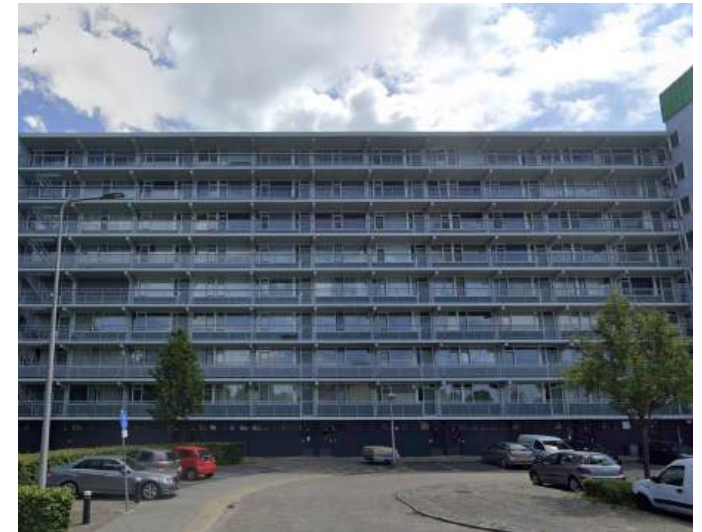
48. Woningen in Marsdiep met een lage energieklasse en versnipperd bezit, wat grootschalige renovatie en het tegengaan van energiearmoede bemoeilijkt
