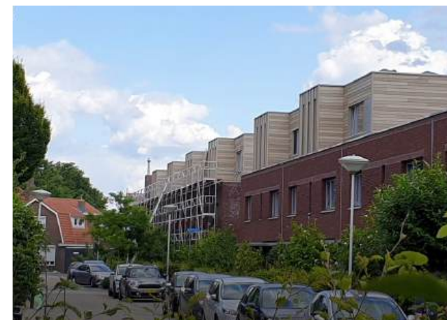
68. Optopping rijwoningen, Breda. Bolier Architecten
