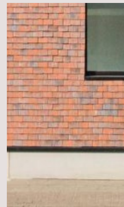
gebruik van secundaire materialen in de gevel
