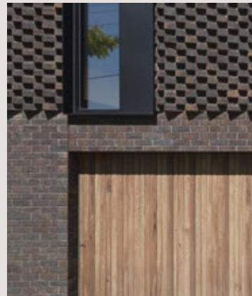
secundair materiaal in de gevel
