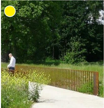
Luchtbrug in een heldere vorm
