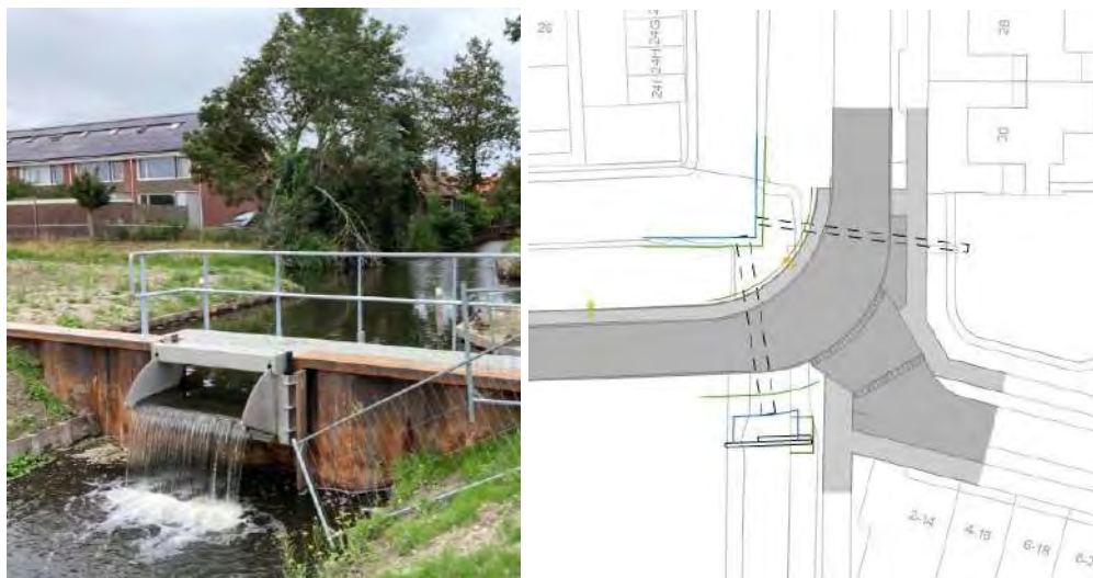
Figuur 13: overzicht huidige situatie stuw t.h.v. Jan van Eycklaan in Hazerswoude-Dorp (links), principetekening nieuwe situatie inclusief duikers in stippellijn (rechts), buitenkade in groen/blauw.
