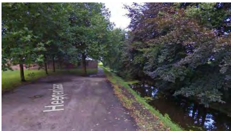
Figuur 20: Huidige structuur Heerenlaan. Bron: Google Streetview, 2019
