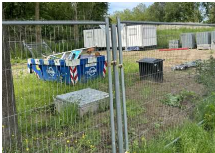
Figuur 4: Parkeerplaats, nu tijdelijk bouwplaats i.v.m. aanleg fietsersbrug
