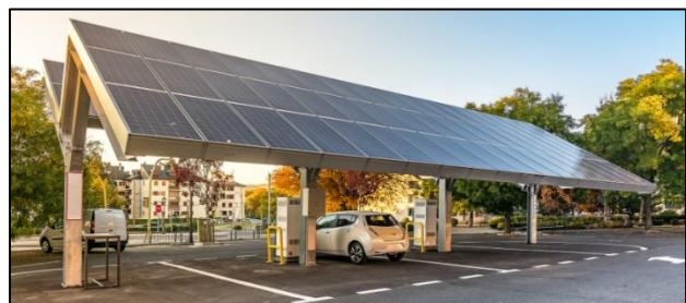
Afbeelding 3: Voorbeeld parkeerdek met zonnepanelen (Wolters engineering, 2023)
