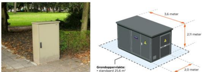
Figuur 1 Voorbeeld van een buitenkast voor laagspanning (l) en afmetingen van een compact station voor middenspanning (r)
