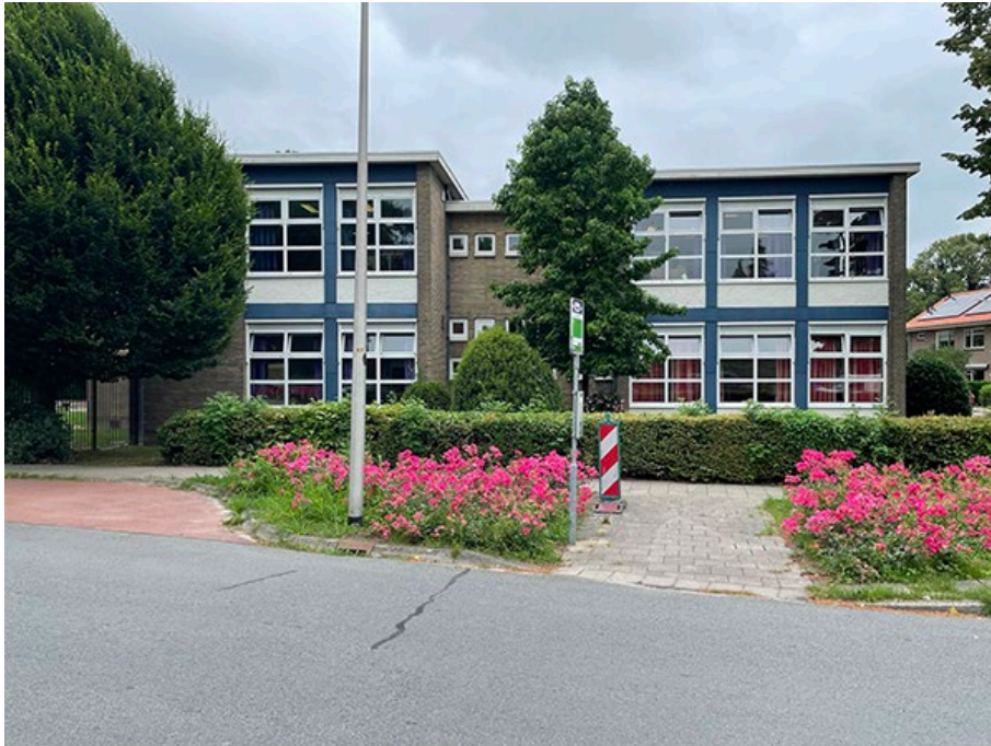
Schoolgebouw aan de Buitendorpstraat, gezien vanaf de Spoorlaan
