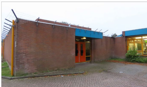
Figuur B2. Arnoldus van Os Zuidplein. Het hogere gebouw is de gymzaal. Er bevinden zich open stootvoegen onder de dakranden.
