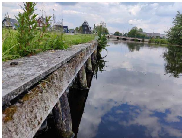
Figuur 10 Hoge hardhouten beschoeiing
