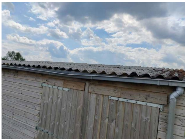
Figuur 14 Golfplaten dak en dubbele houten deur van de schuur
