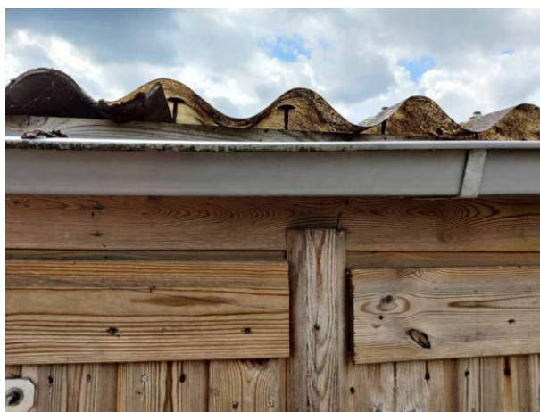
Figuur 12 Ruimte onder zwarte golfplaten direct in verbinding met binnenruimte van schuur
