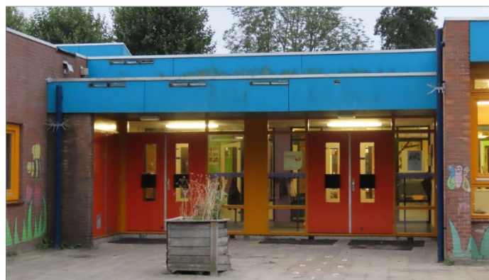
Figuur B1. Arnoldus van Os Noordplein. Alle schoolgebouwen zijn enkel laags. Onder de dakrand van de bakstenenmuren bevinden zich over de gehele lengte open stootvoegen.
