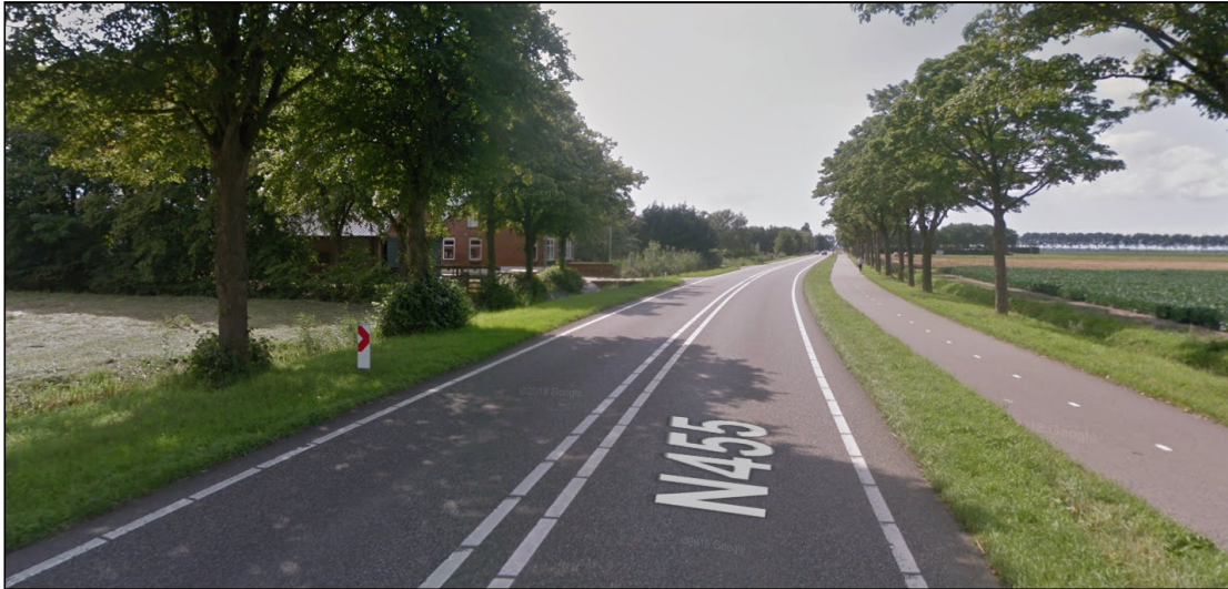
Figuur 2.1: De N455 Hogeveenseweg ter plaatse van de planlocatie
